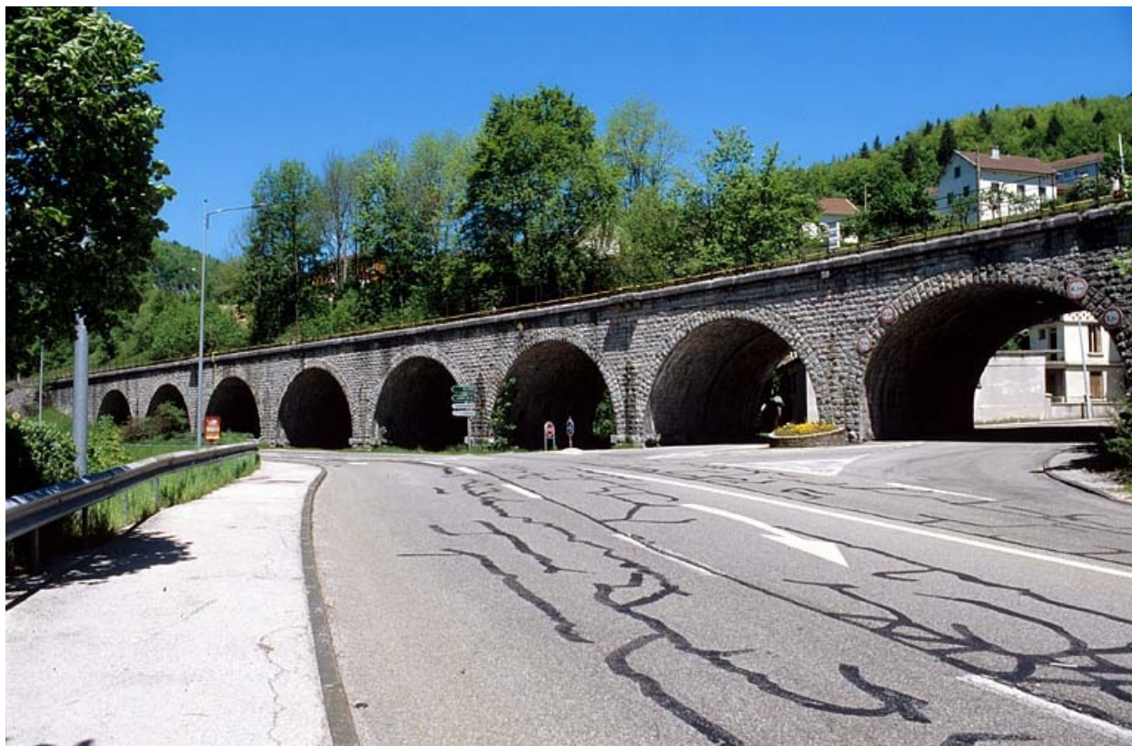
Elévation orientale, vue de trois quarts droite.
