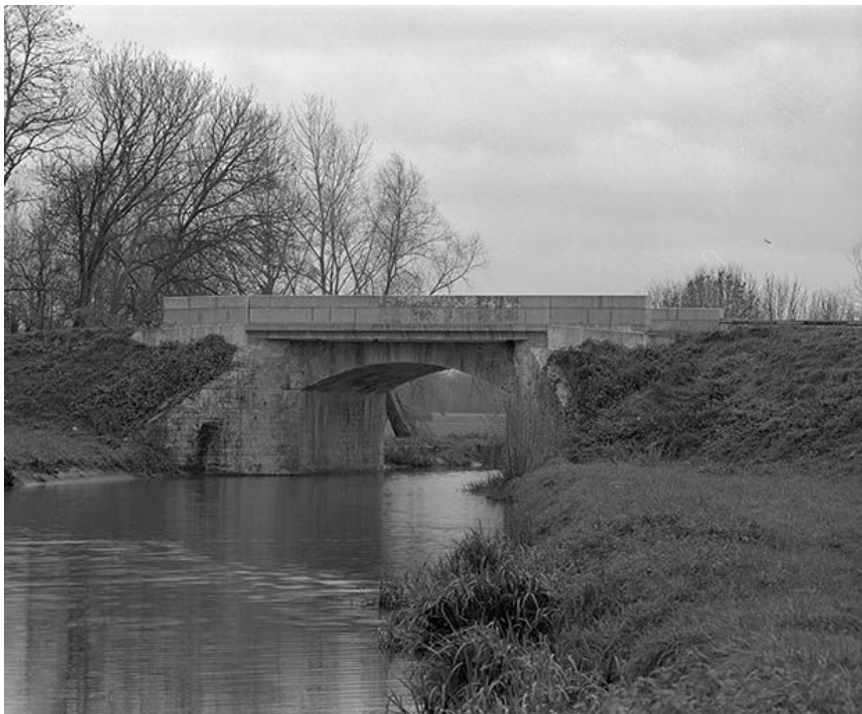
Vue d'ensemble prise de l'aval
