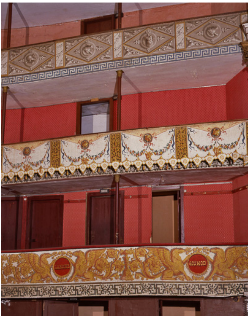
Elévation des balcons et décor peint (1987).
