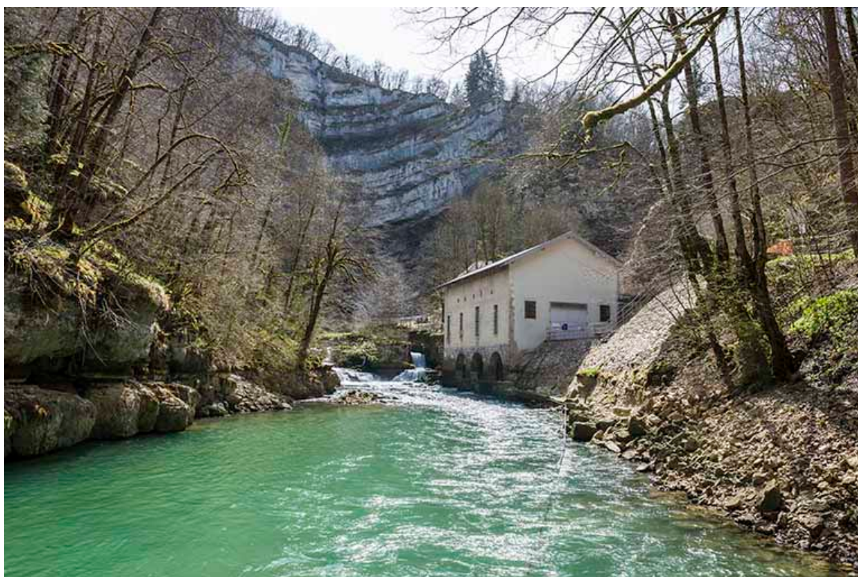
Vue générale depuis l'aval.
