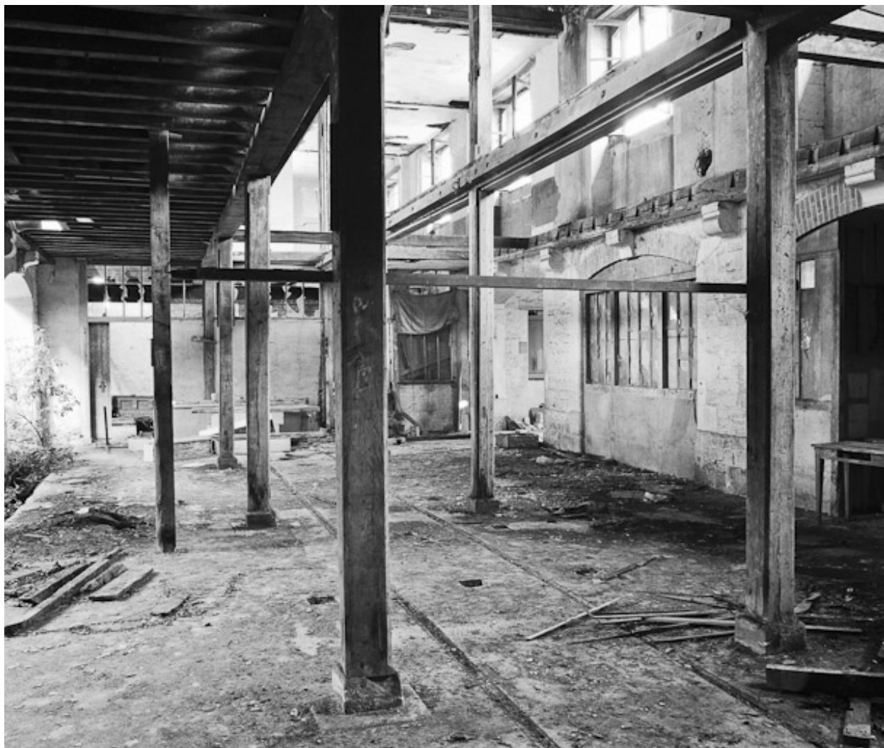
État en 1984, vue intérieure.
