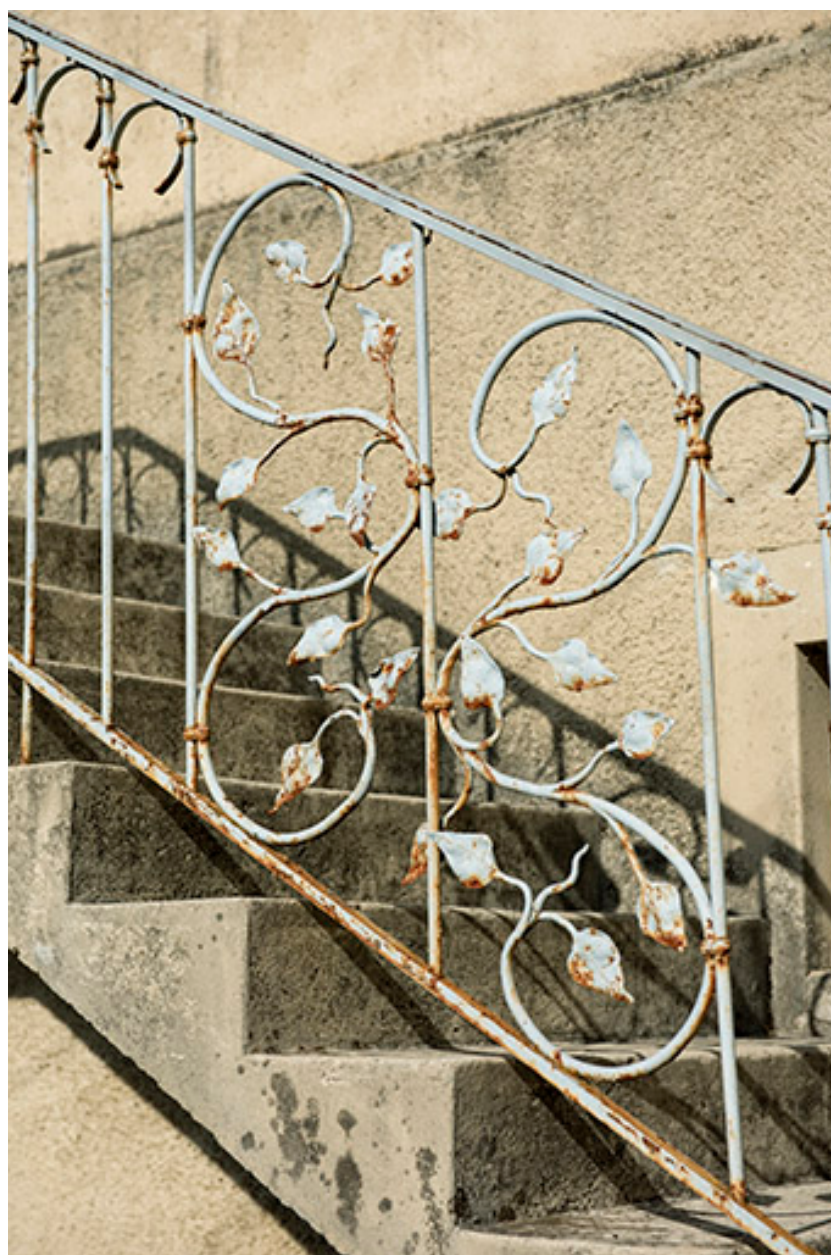
Maison de 1924 : ferronnerie du garde-corps de l'escalier.
