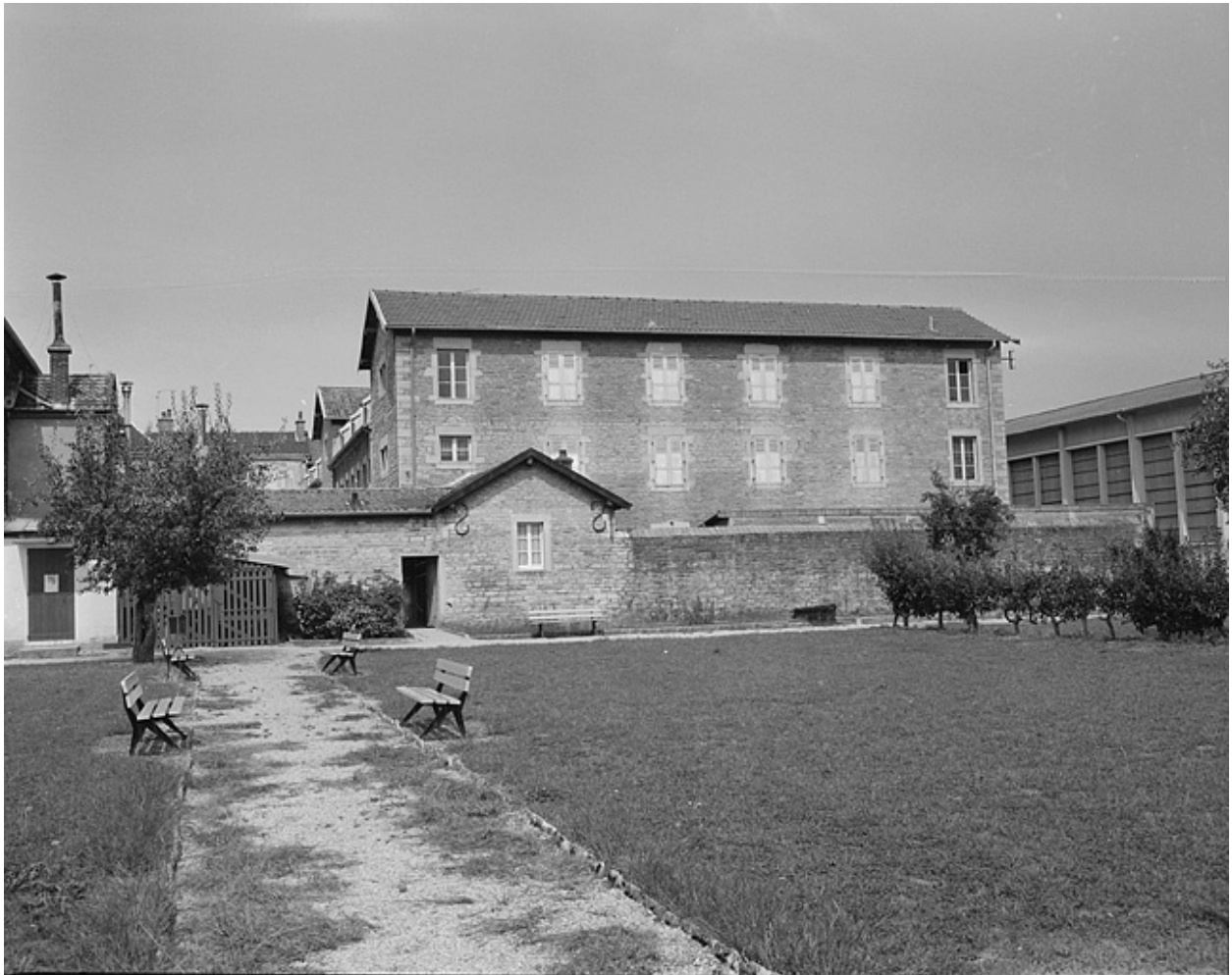
Façade latérale d'un des pavillons en1983.
