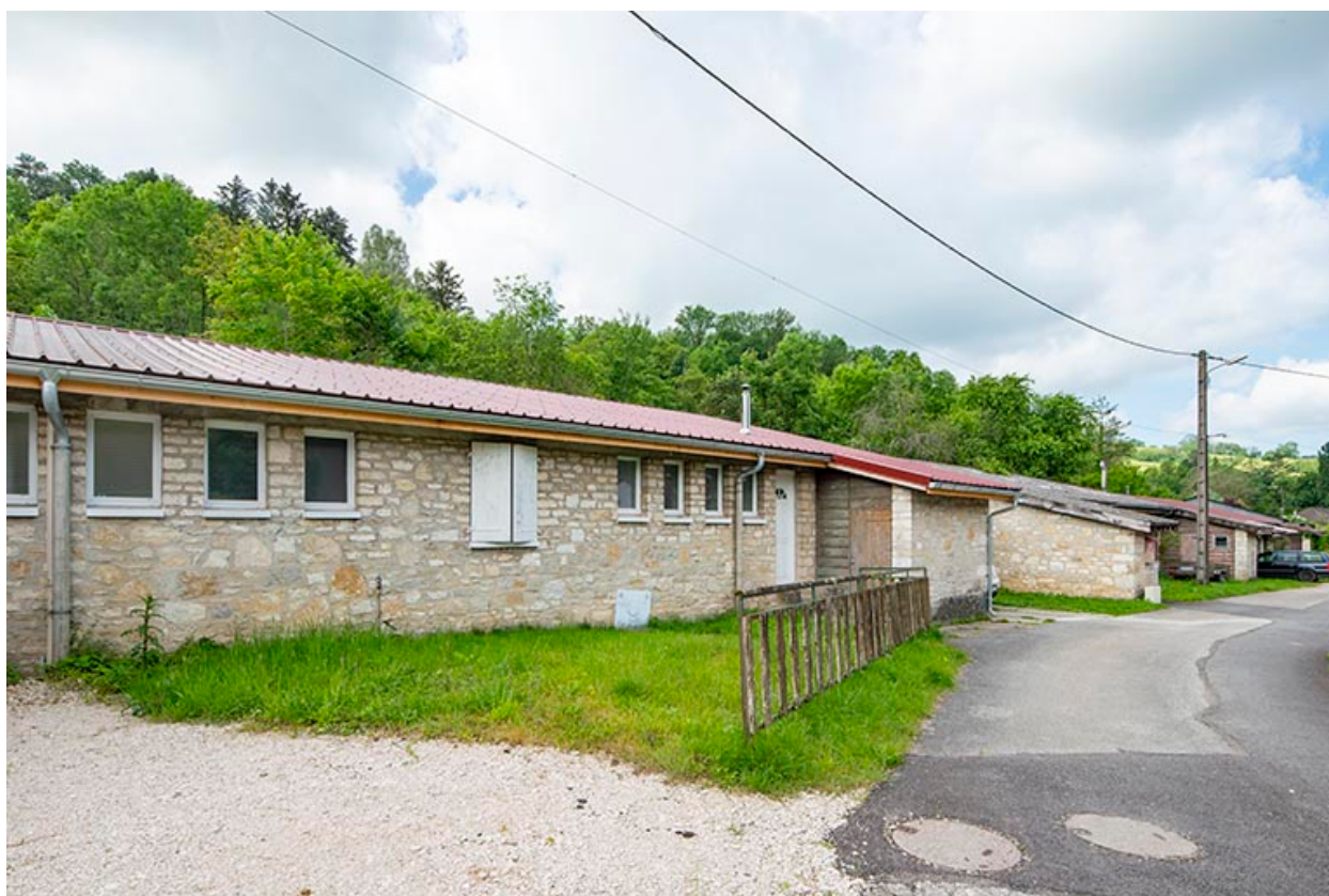
Vue d'ensemble des maisons jumelées.
