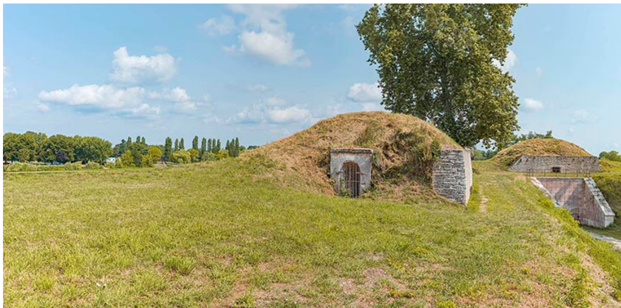
Entrée d'une des casemates sur le terre-plein.
