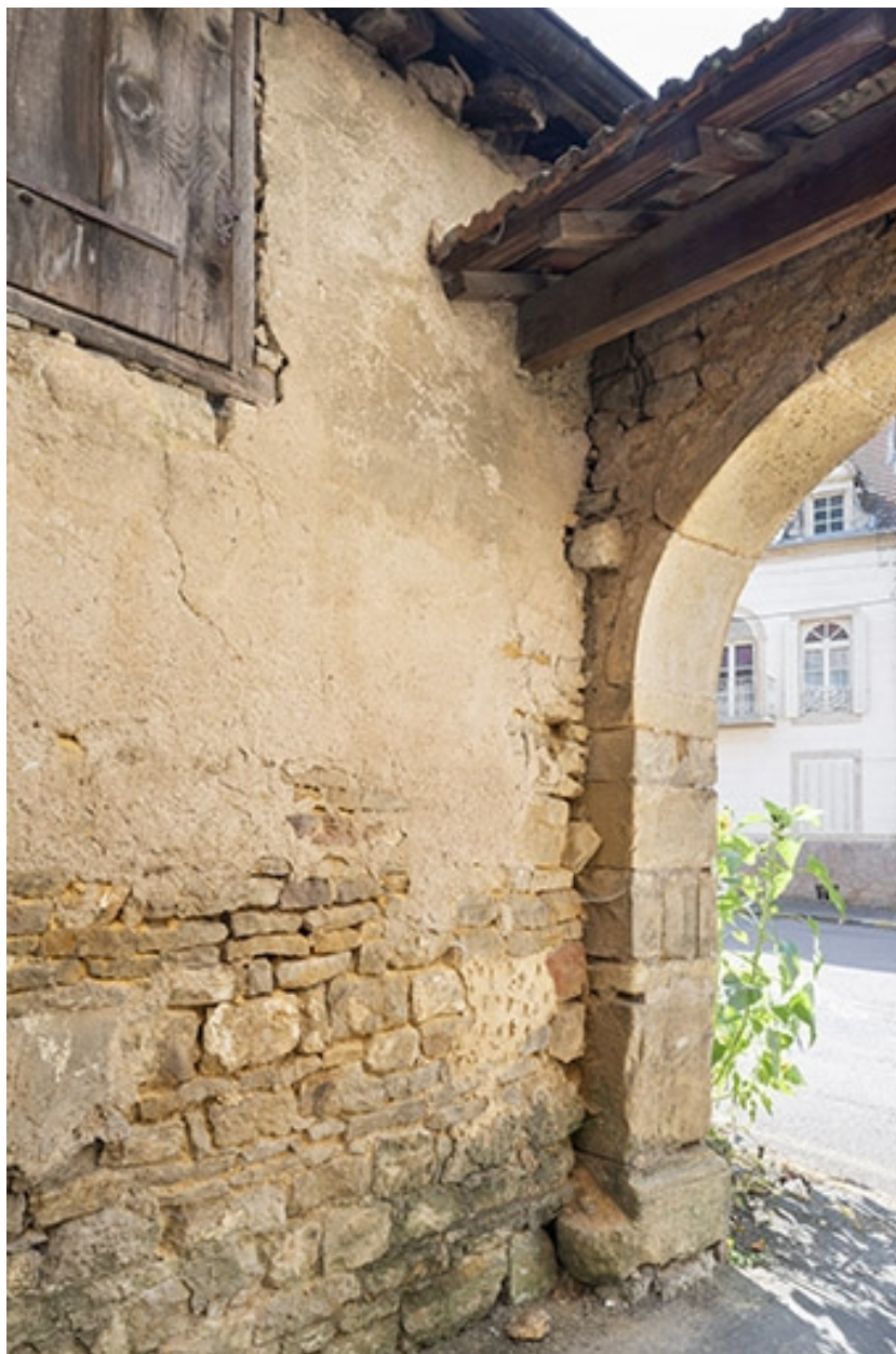
Détail de maçonnerie depuis la cour.
