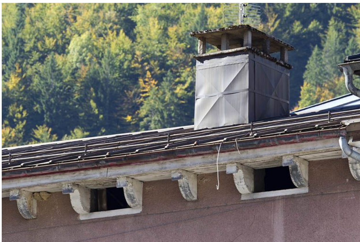
Corniche et ses corbeaux.
