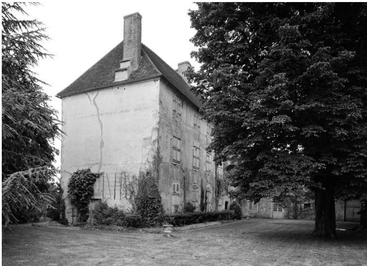
Bâtiment est. Vue d'ensemble.
