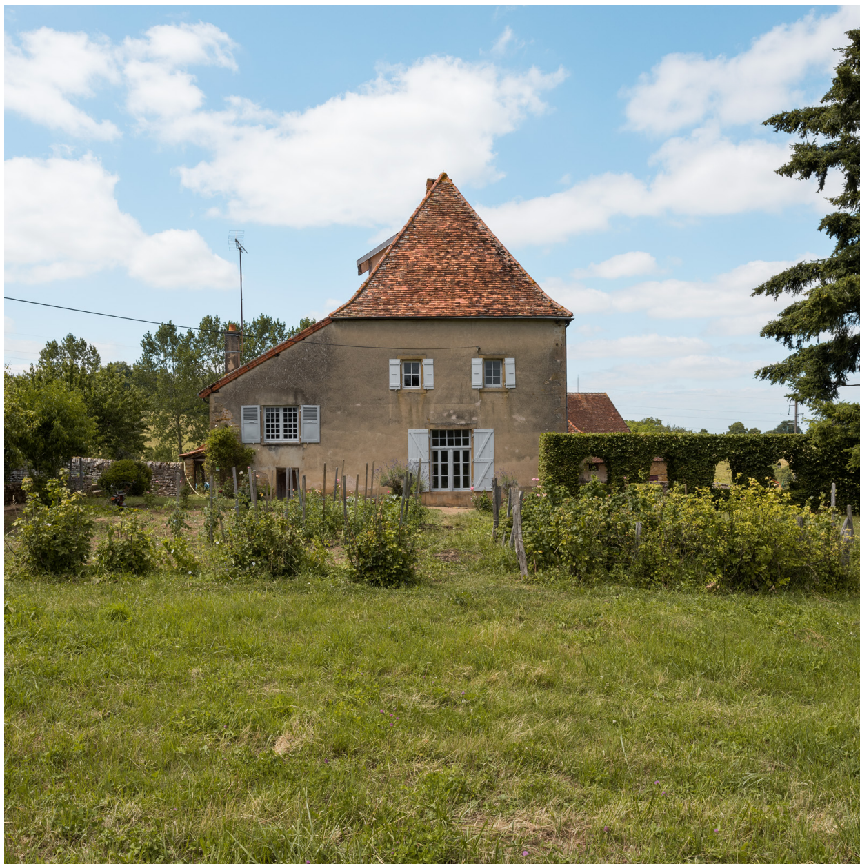
Façade sud du logement.
