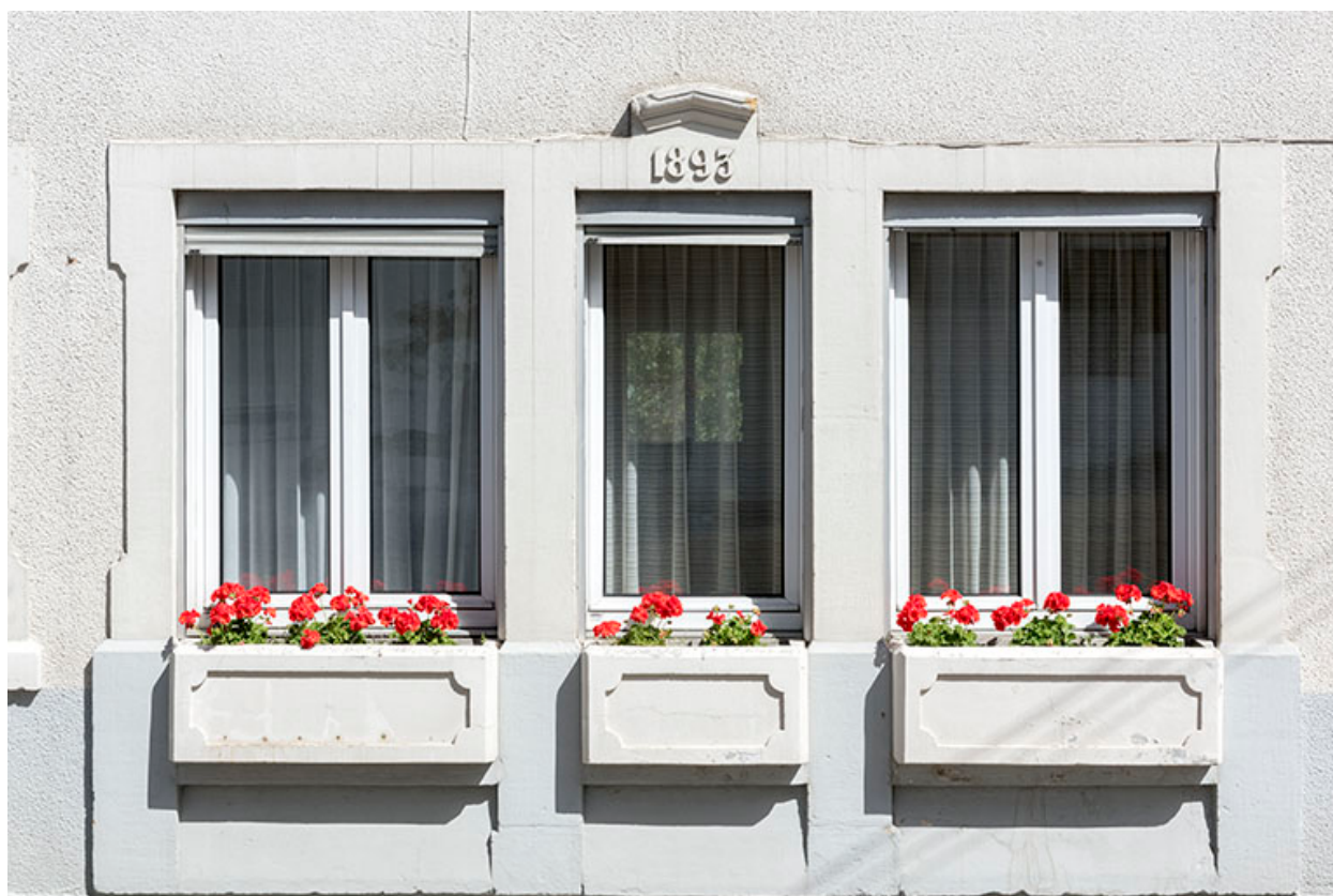
Façade antérieure : linteau daté.
