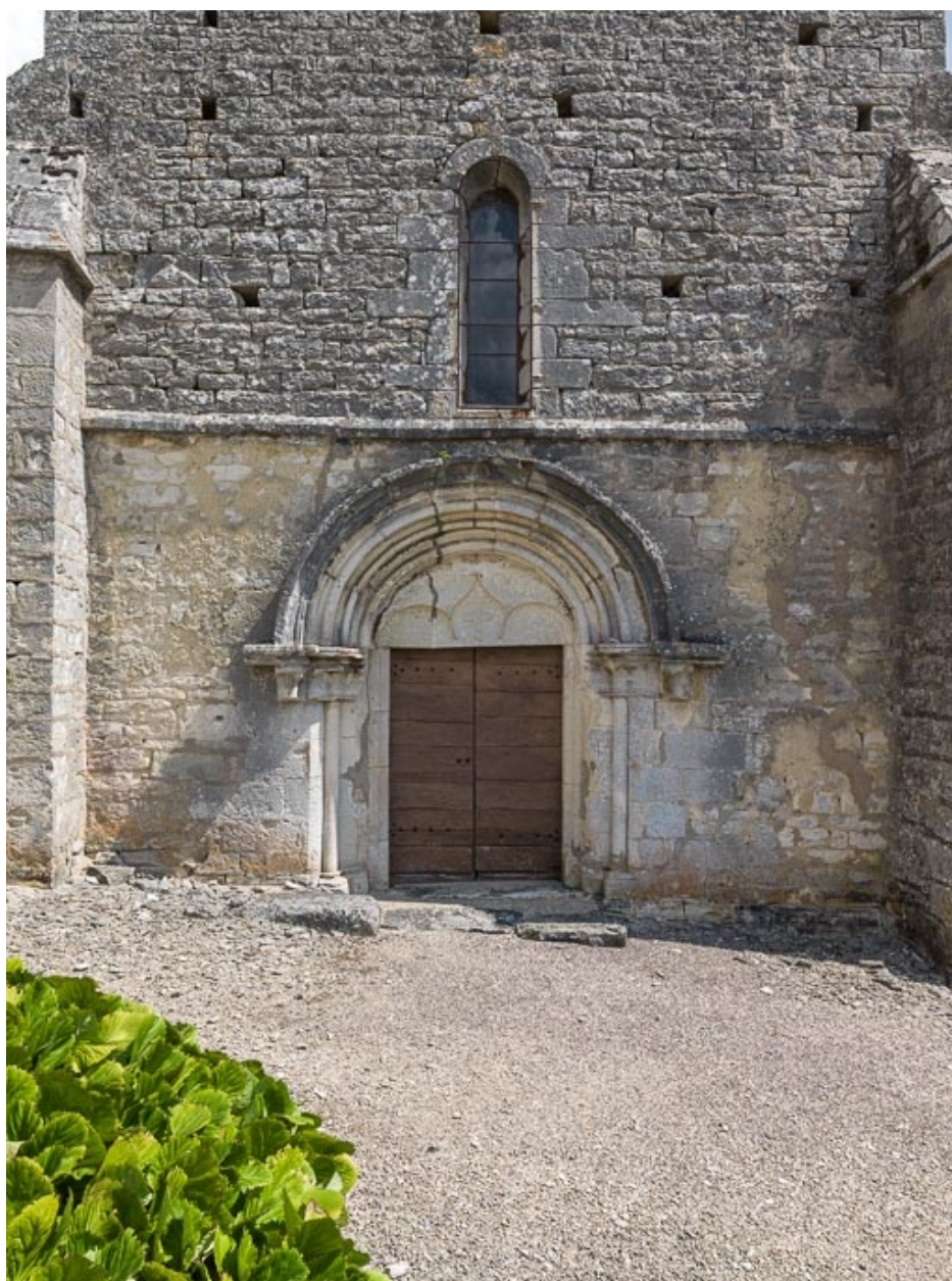
Portail et baie de la façade.
