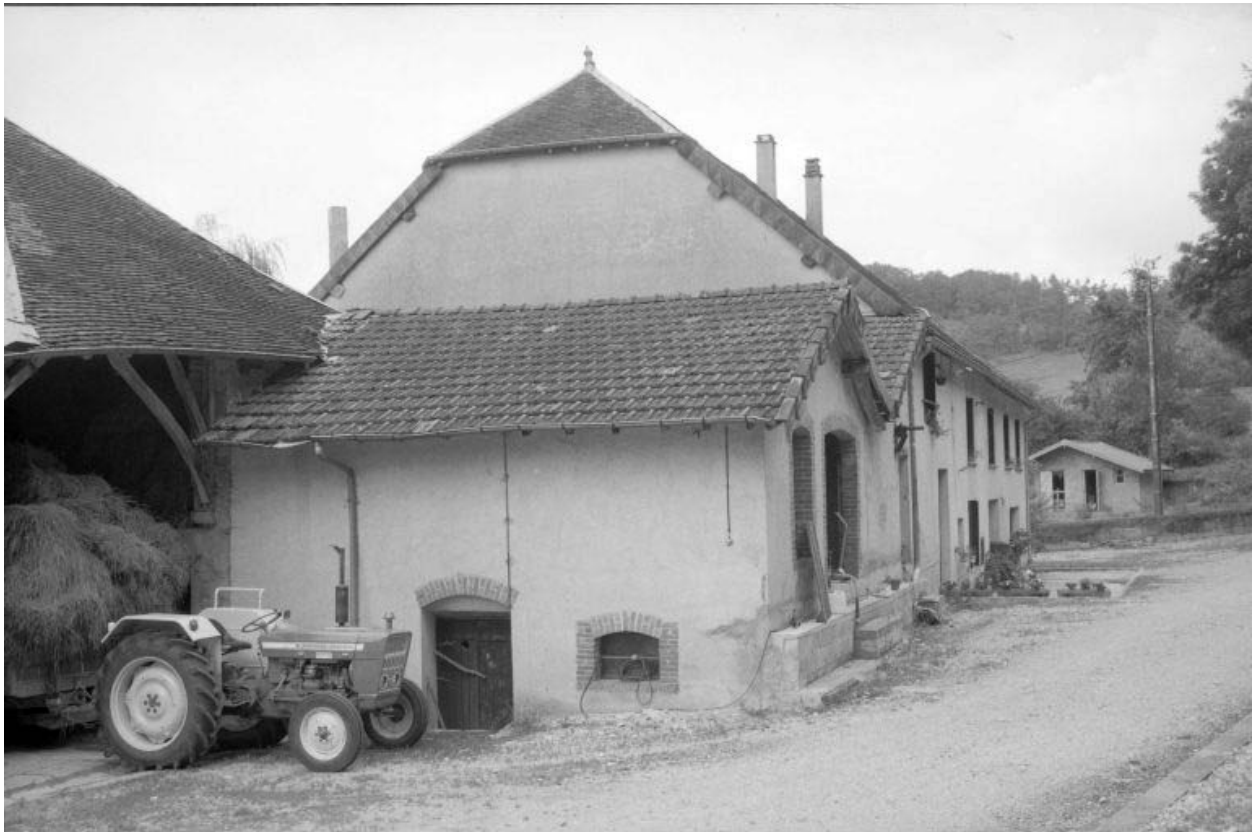
Bâtiment d'eau et atelier de fabrication.
