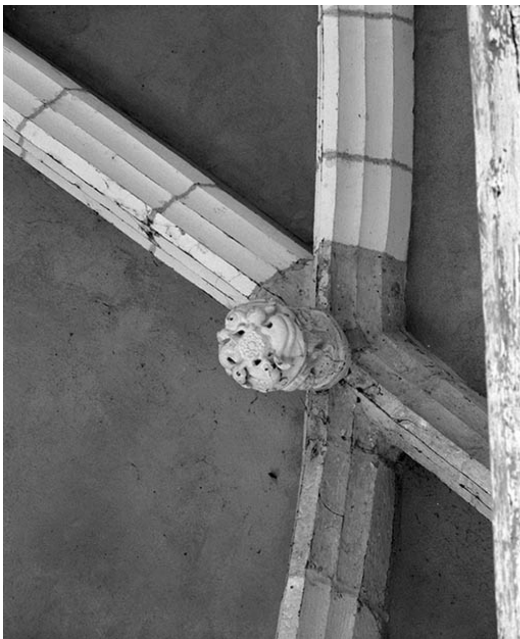
Choeur, détail : clef de voûte.
