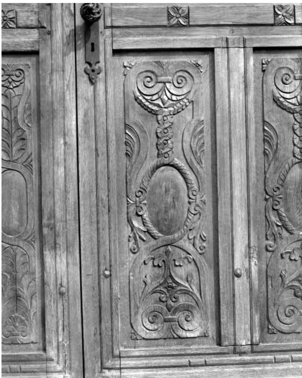
Détail de la porte du logis.
