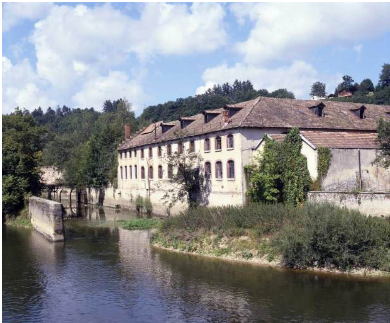
Bâtiment industriel en 1986 (cliché inversé).
