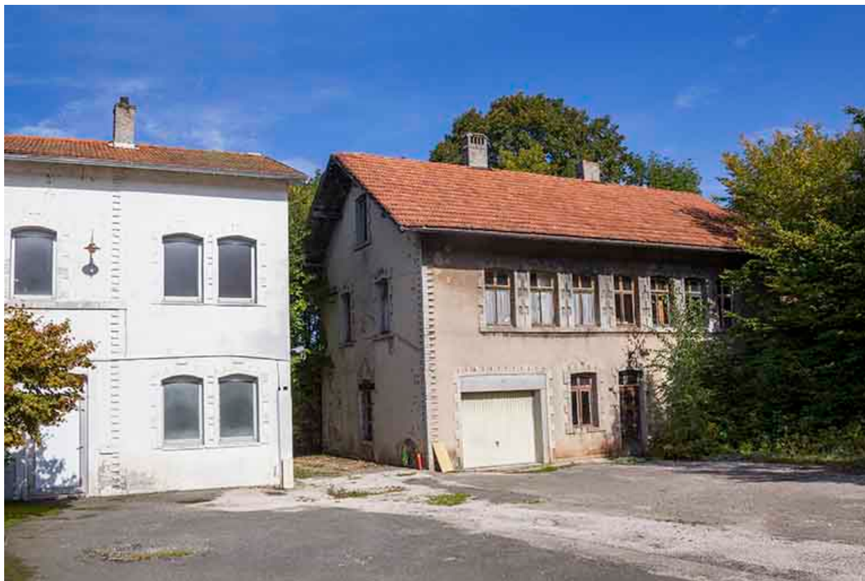
Vue d'ensemble, depuis le sud.
