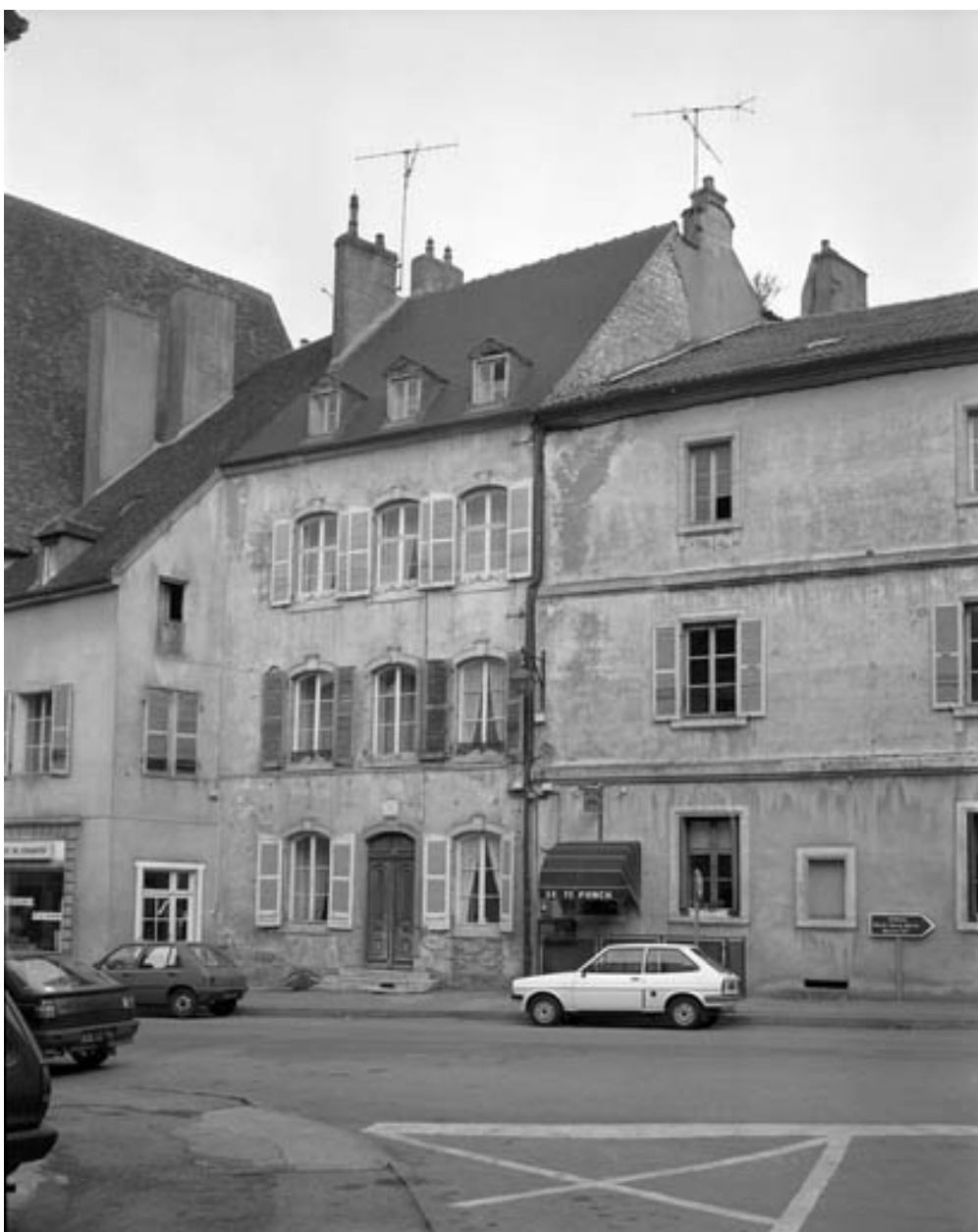
Façade antérieure du 8 rue du Marché.
