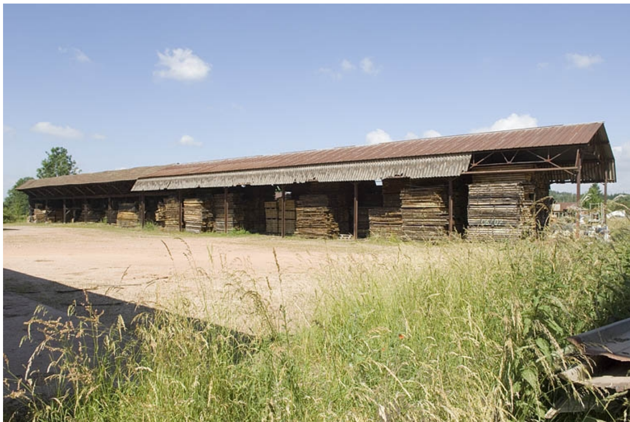
Entrepôt industriel ouest. Vue d'ensemble.
