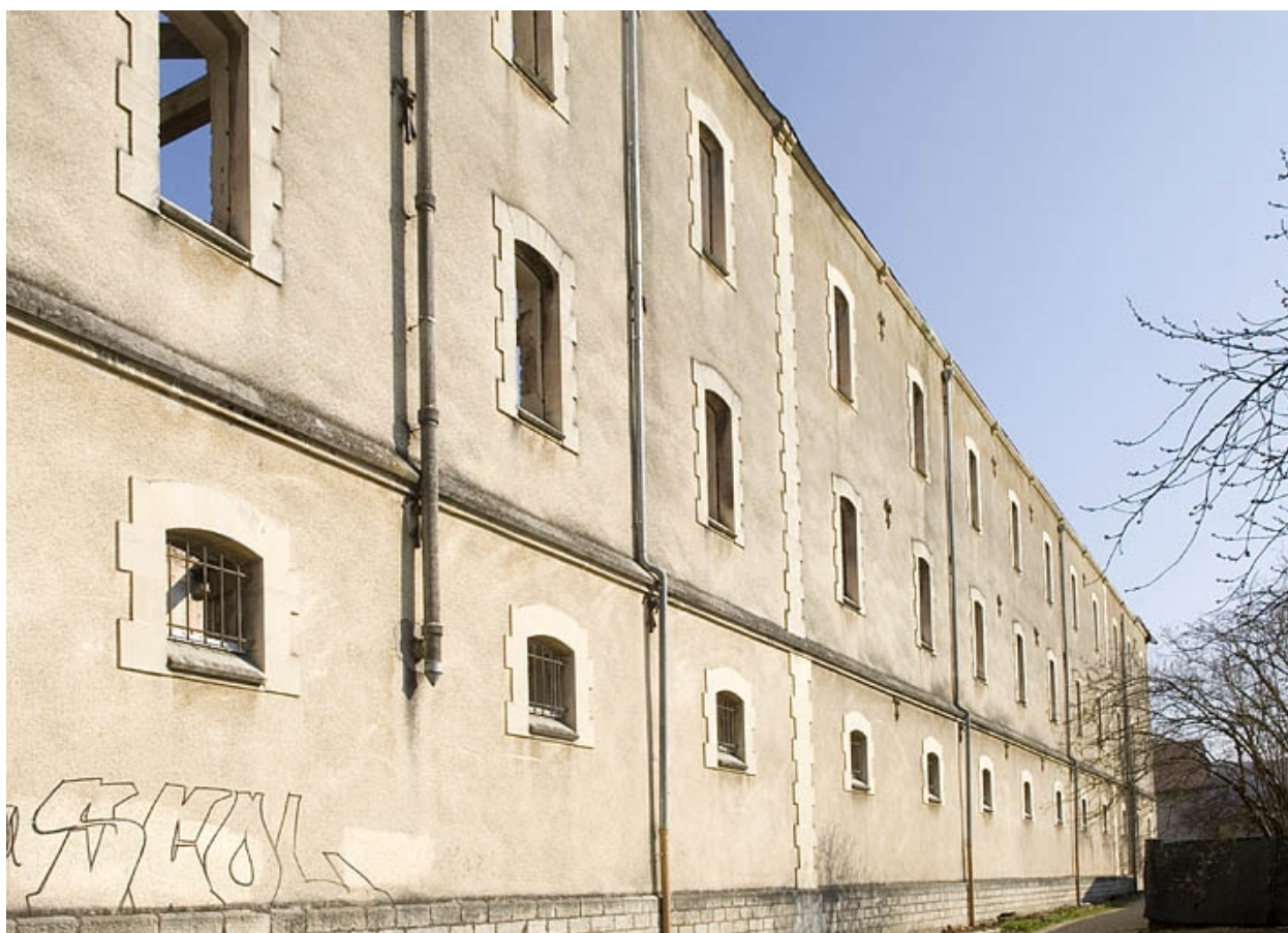
Aile ouest. Façade occidentale.
