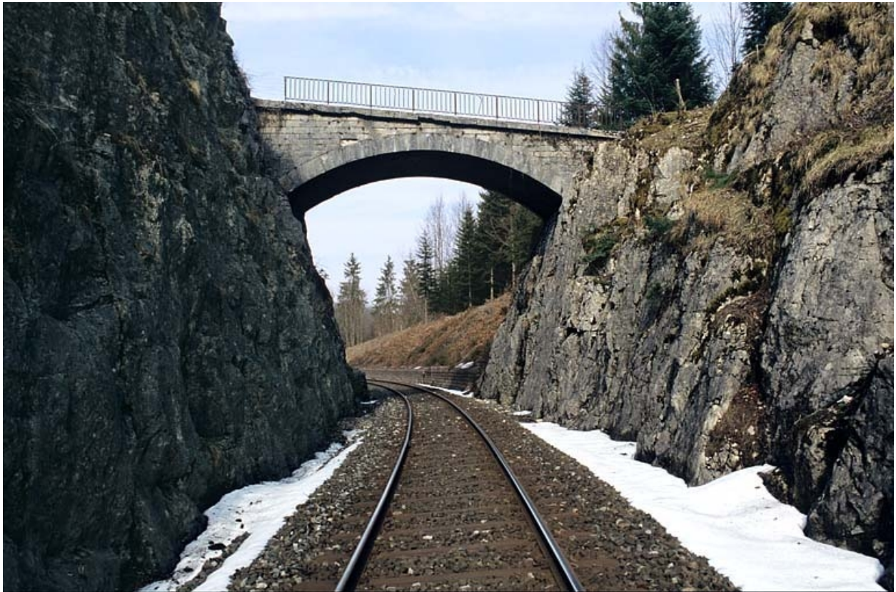
Vue d'ensemble, depuis la voie (côté Andelot-en-Montagne).
