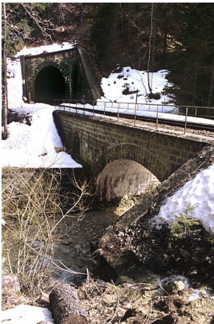
Vue d'ensemble, depuis le nord-ouest (amont).
