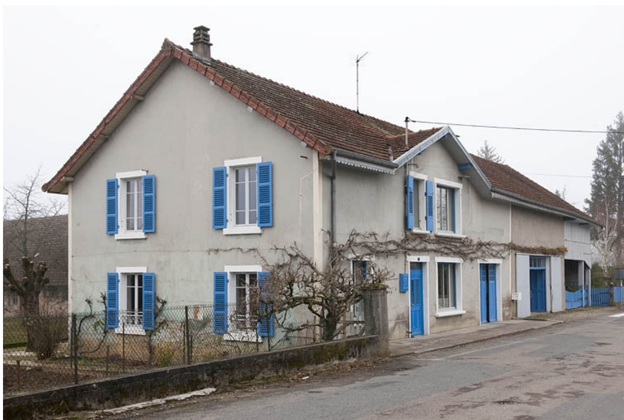
Façade antérieure et façade latérale gauche.
