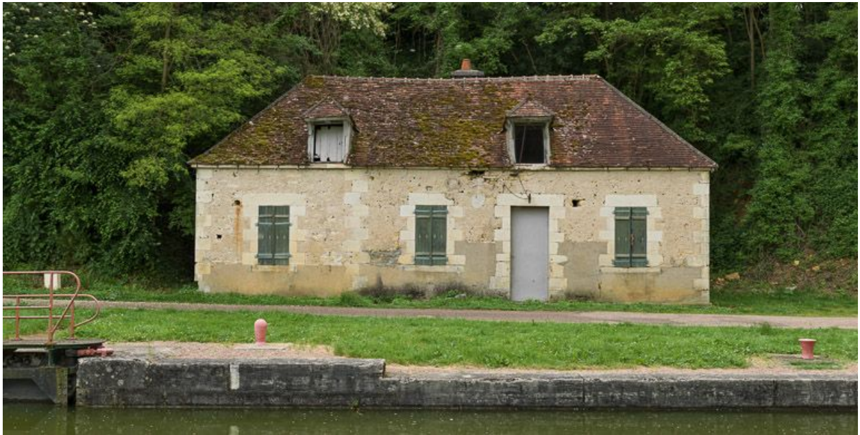
Vue de face de la maison éclusière.
