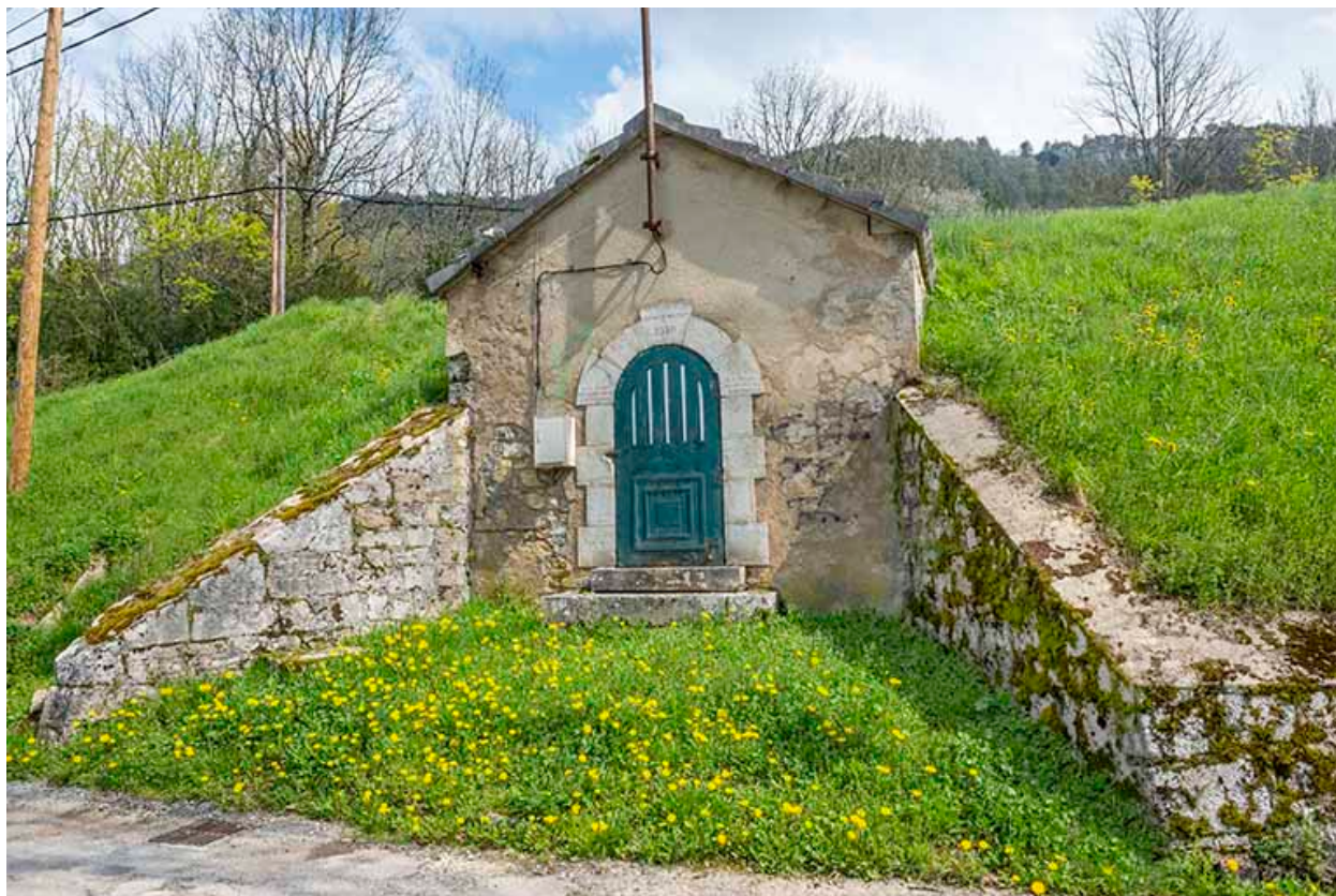
Réservoir de Chambenoz (1910). Côté ouest.
