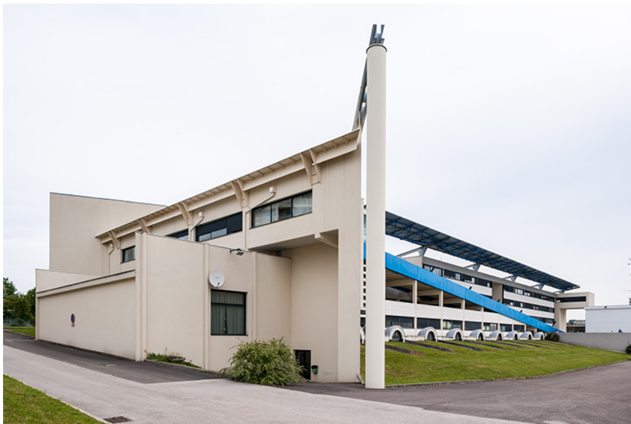
Bâtiment d'externat : pignon ouest.
