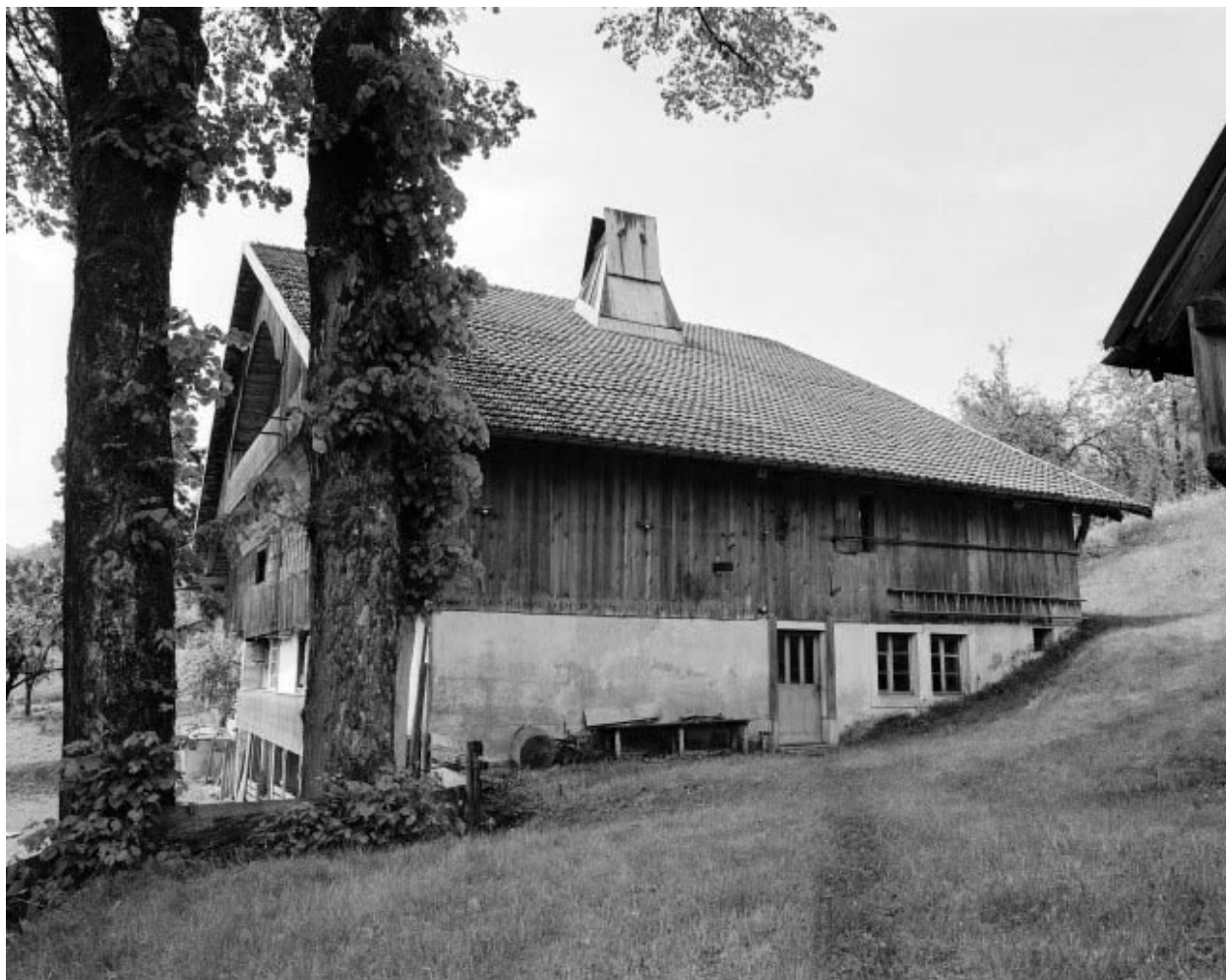
Extérieur : façades antérieure et latérale droite.
