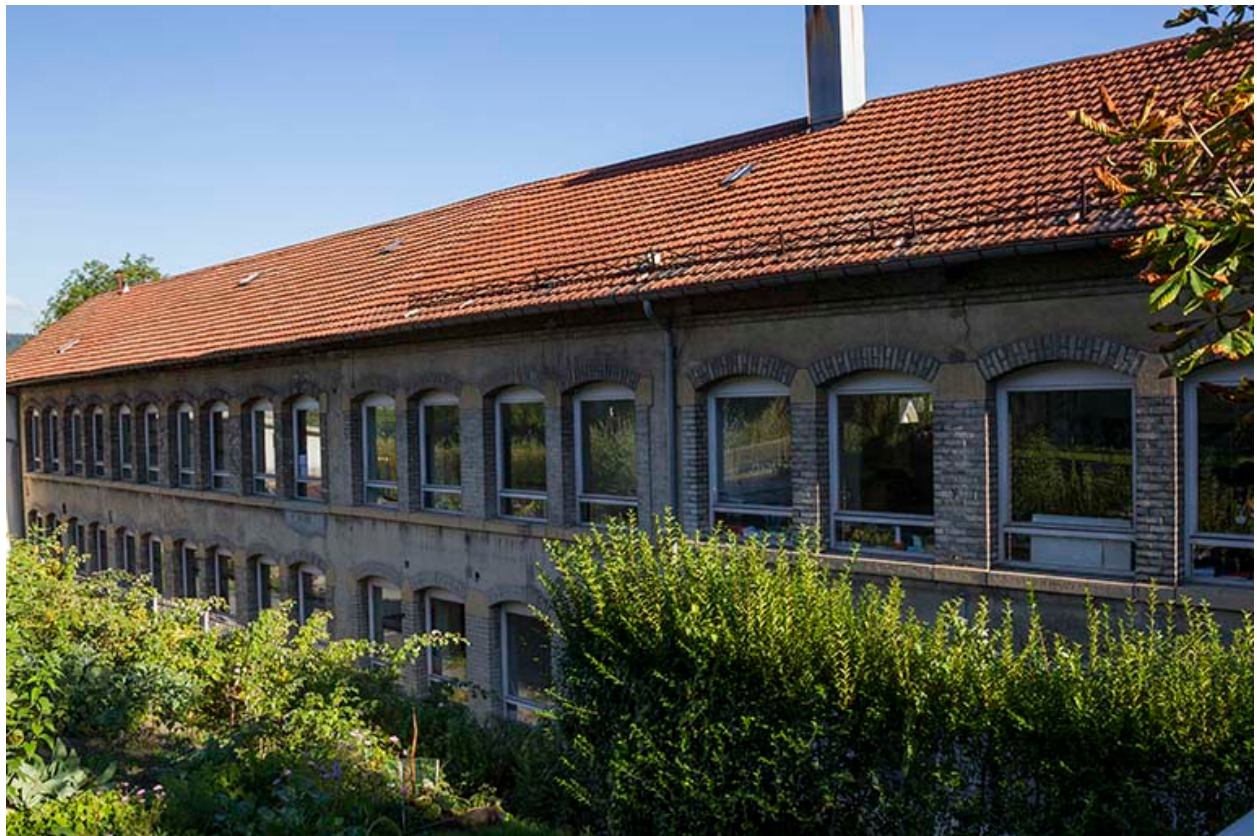
Aile nord : façade postérieure.
