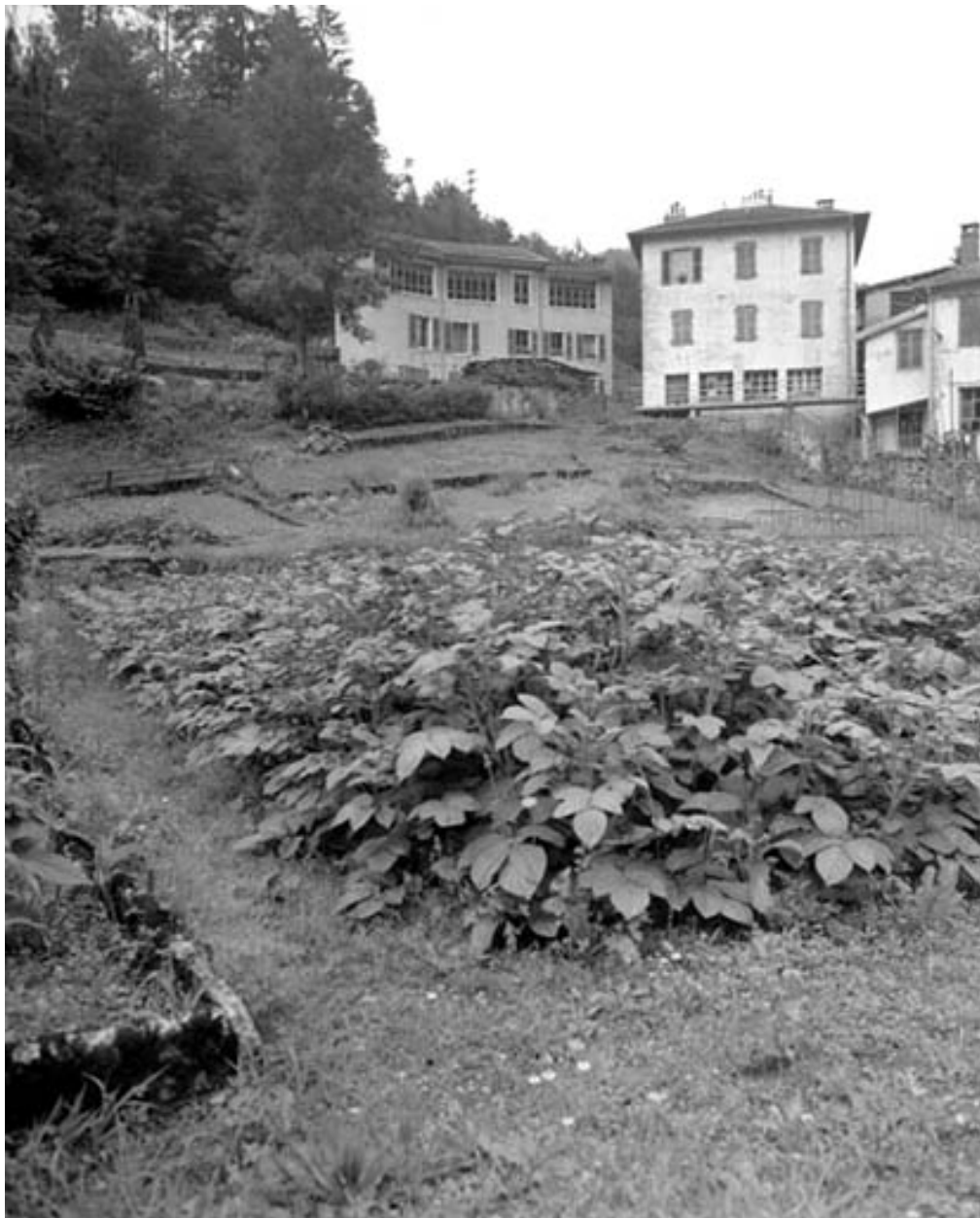
Bureau et logements, depuis les jardins ouvriers.
