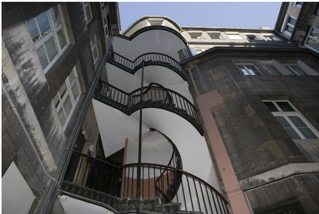
Vue d'ensemble de l'escalier à cage ouverte.
