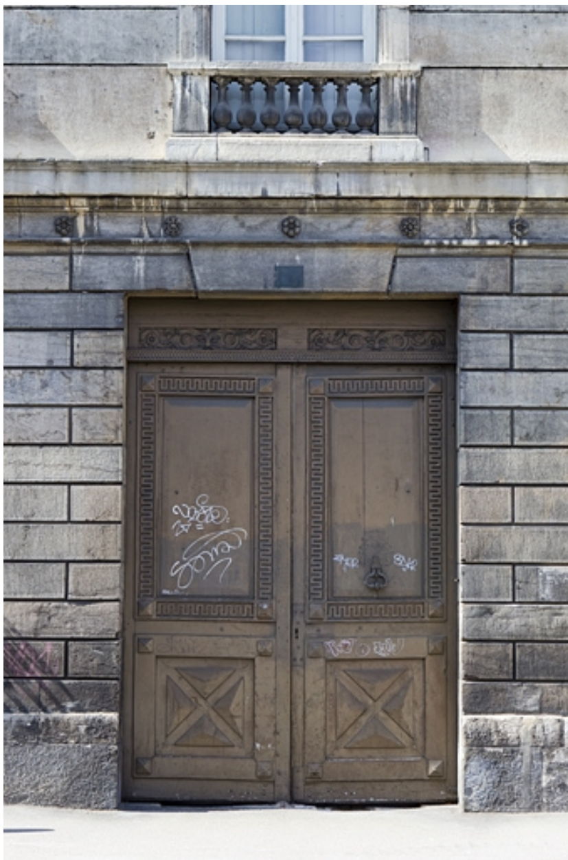
Façade antérieure : détail du portail d'entrée.
