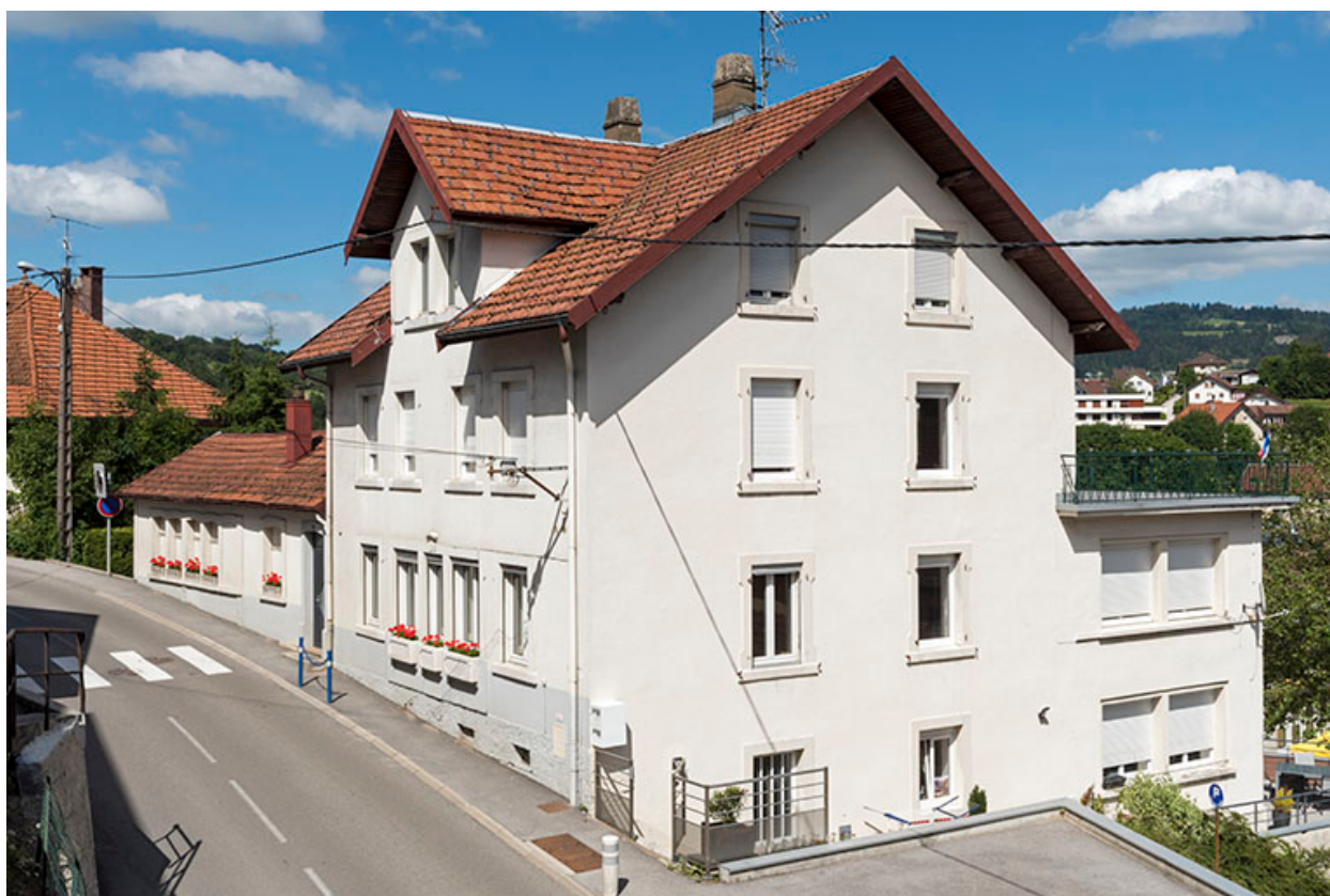
Façades antérieure et latérale droite.
