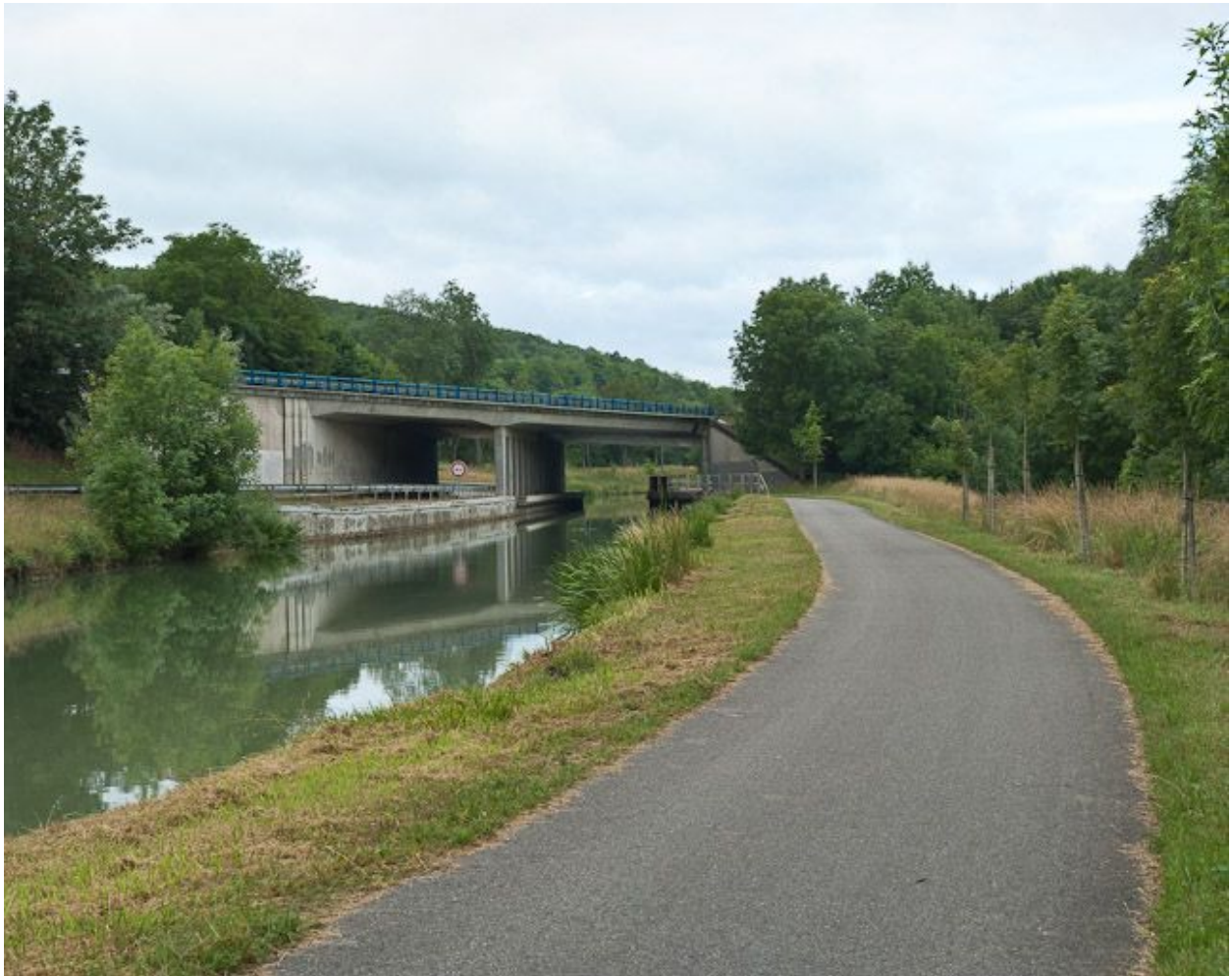
Vue d'ensemble du pont.
