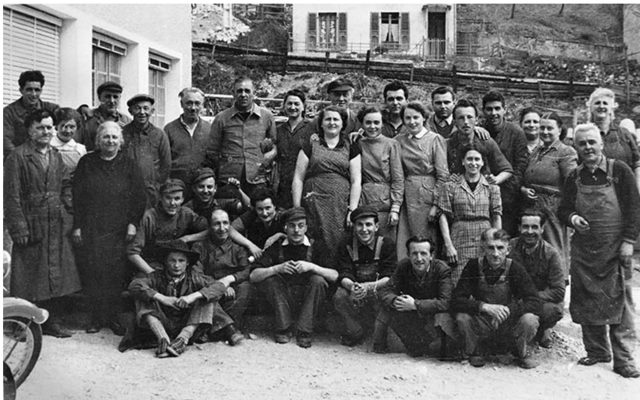
Le personnel de l'usine.
