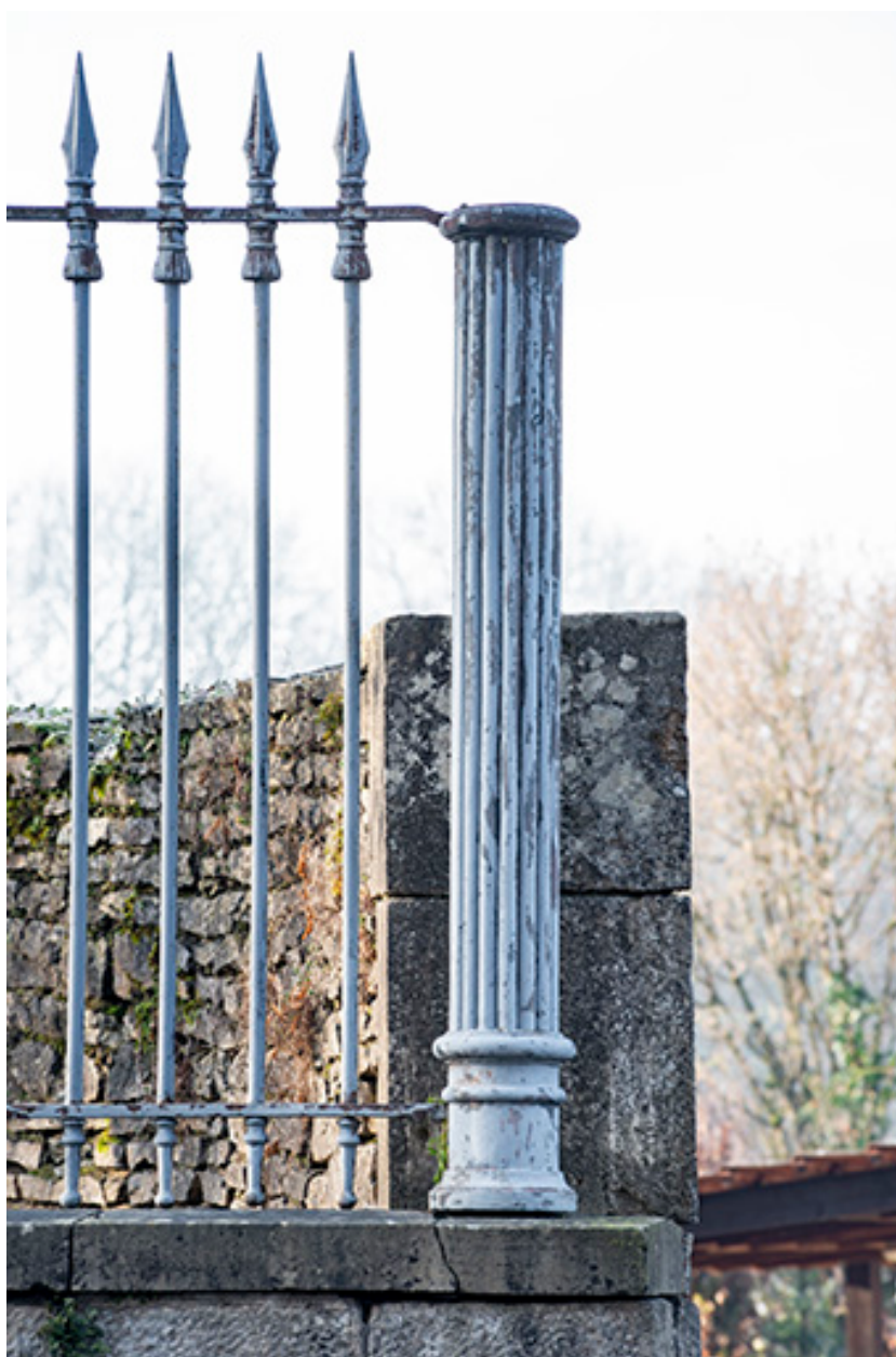
Clôture (grille) sur l'avenue des Pâtis.
