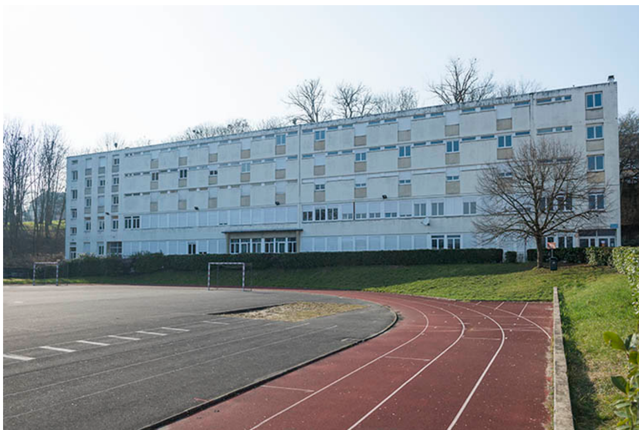
Stade, façade antérieure (est) de l'internat.
