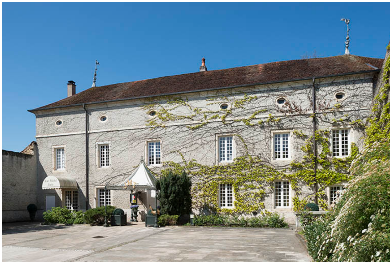
La façade principale.
