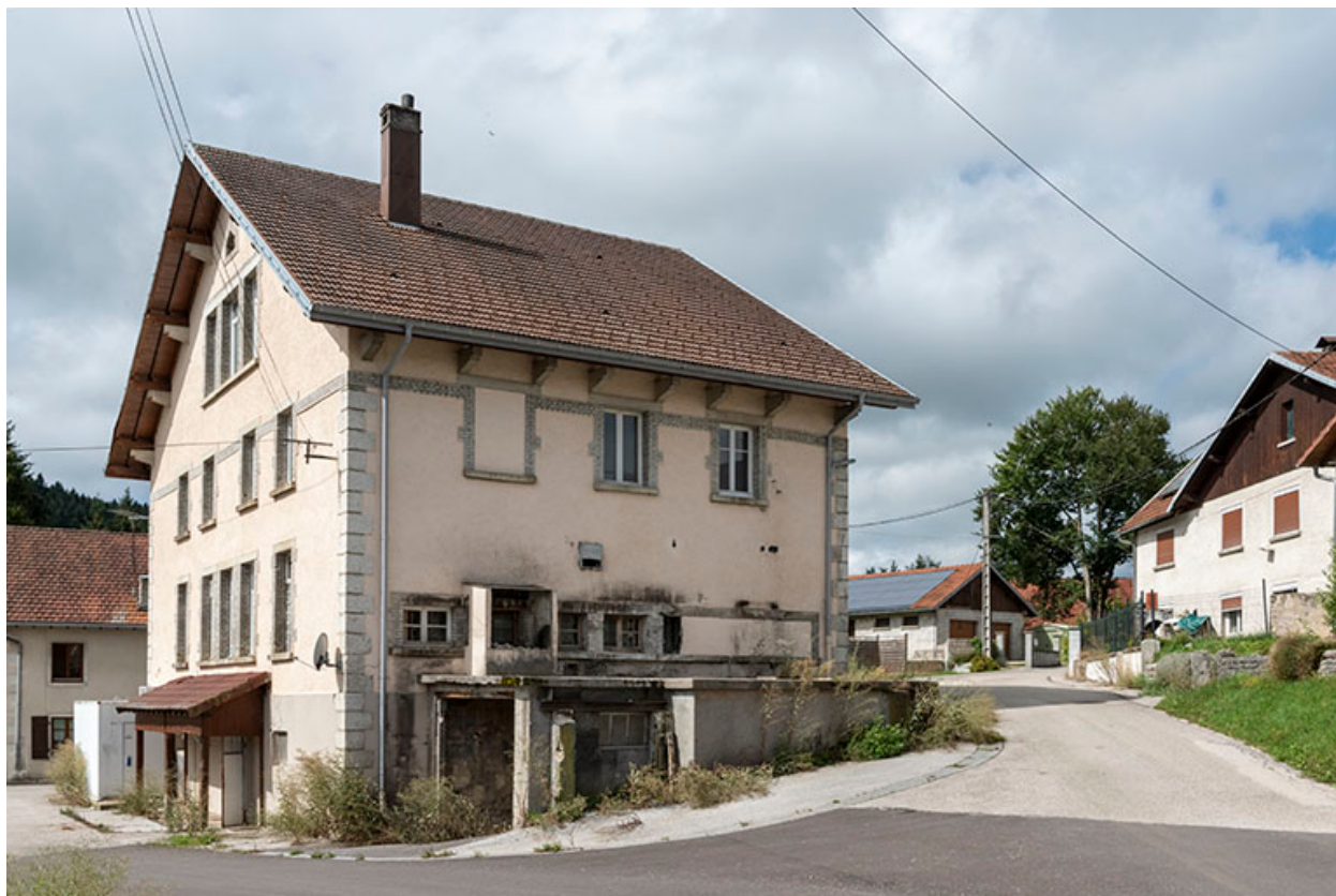
Façades postérieure et latérale gauche.
