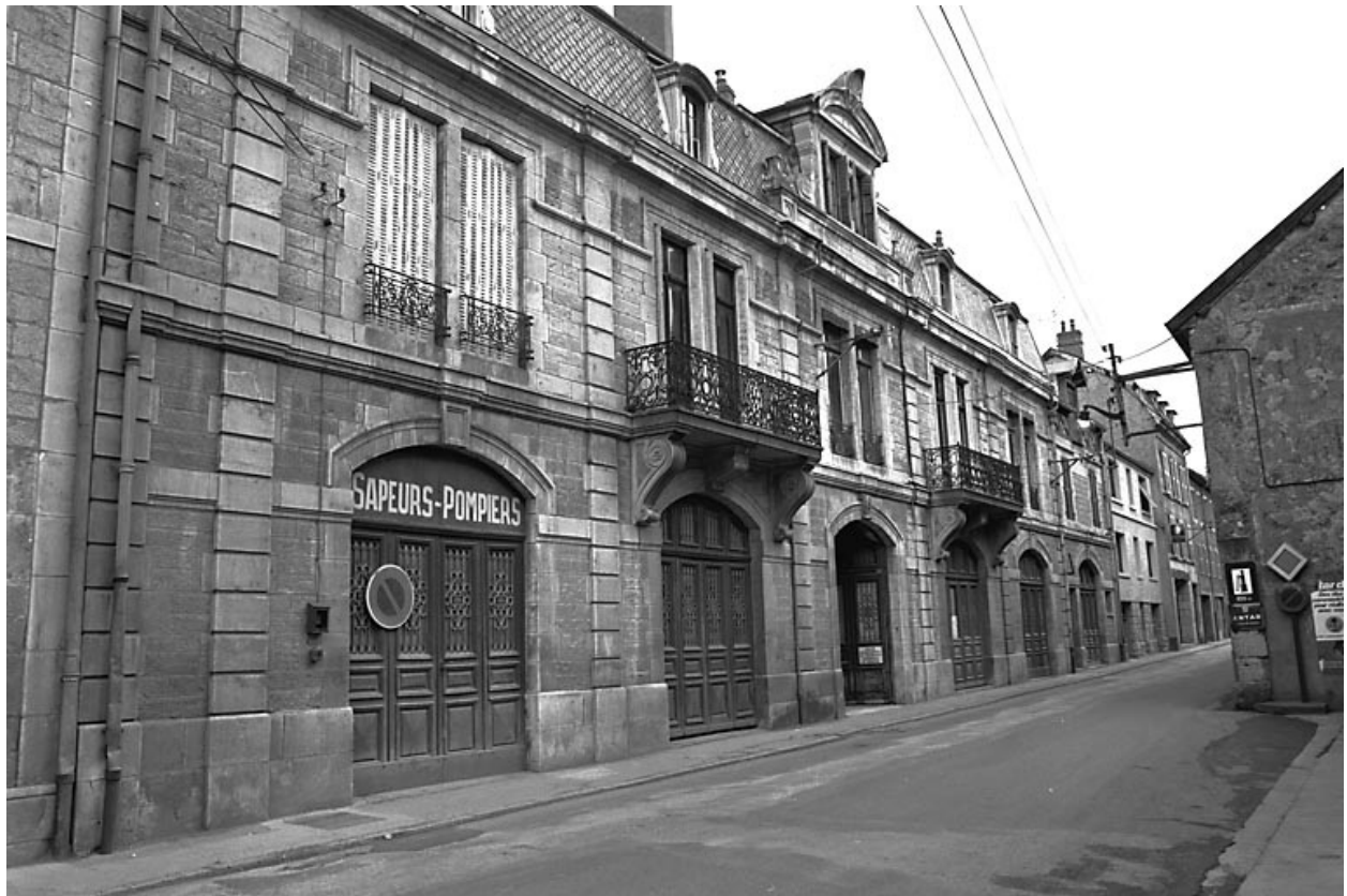
Façade antérieure de l'atelier sur rue (1977).
