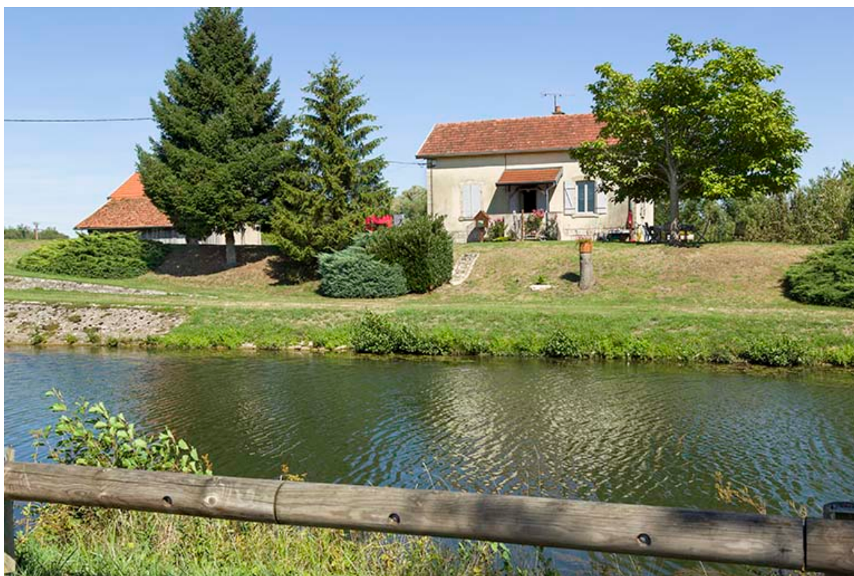
Maison du barragiste.
