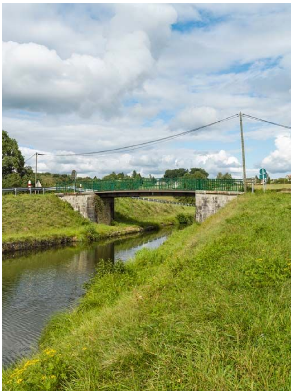
Vue d'ensemble du pont.
