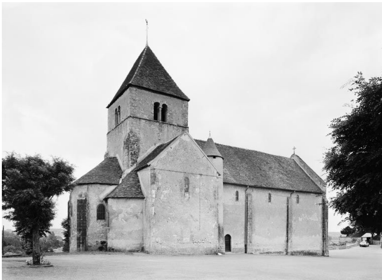
Elévation latérale gauche, vue prise du nord-est.
