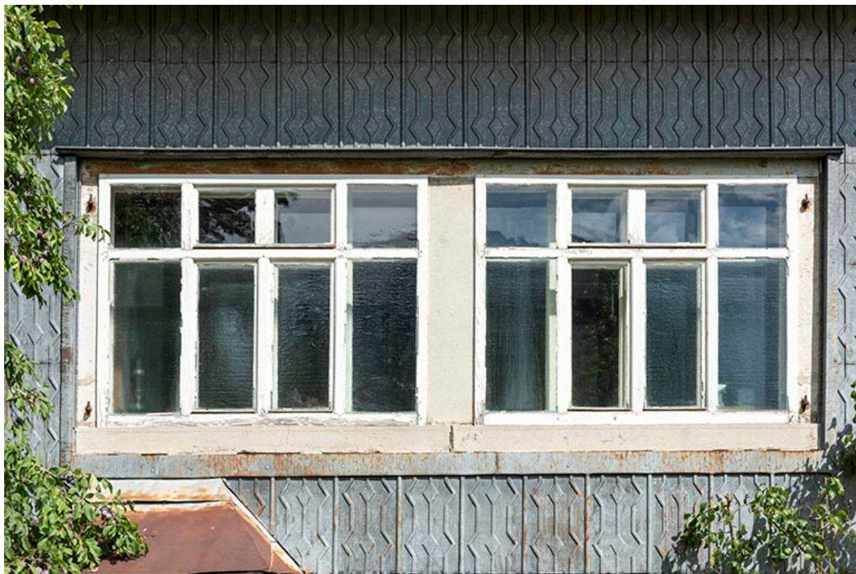
Façade latérale gauche : fenêtres de l'atelier.
