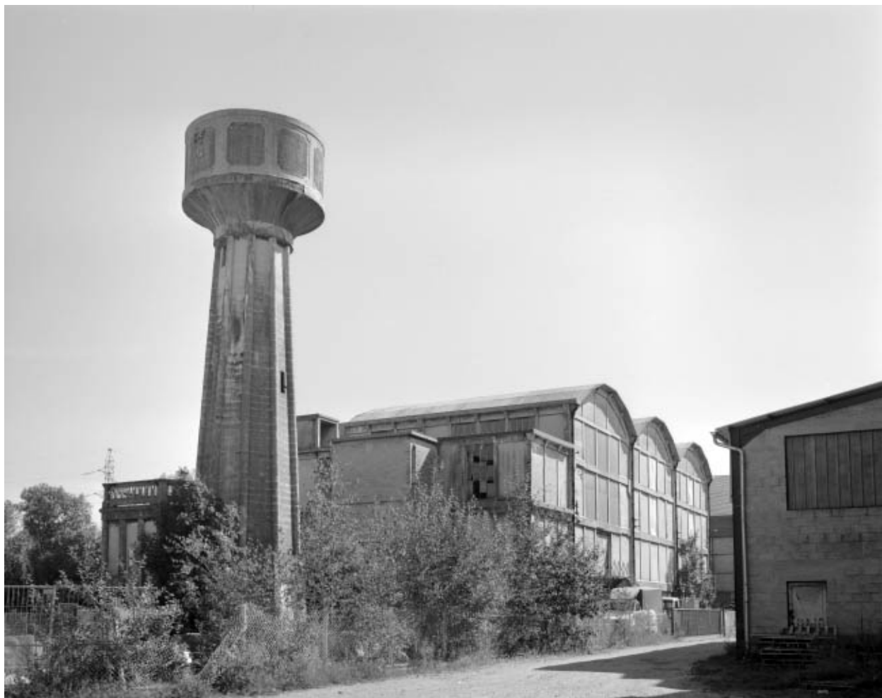
Le château d'eau et la centrale thermique.
