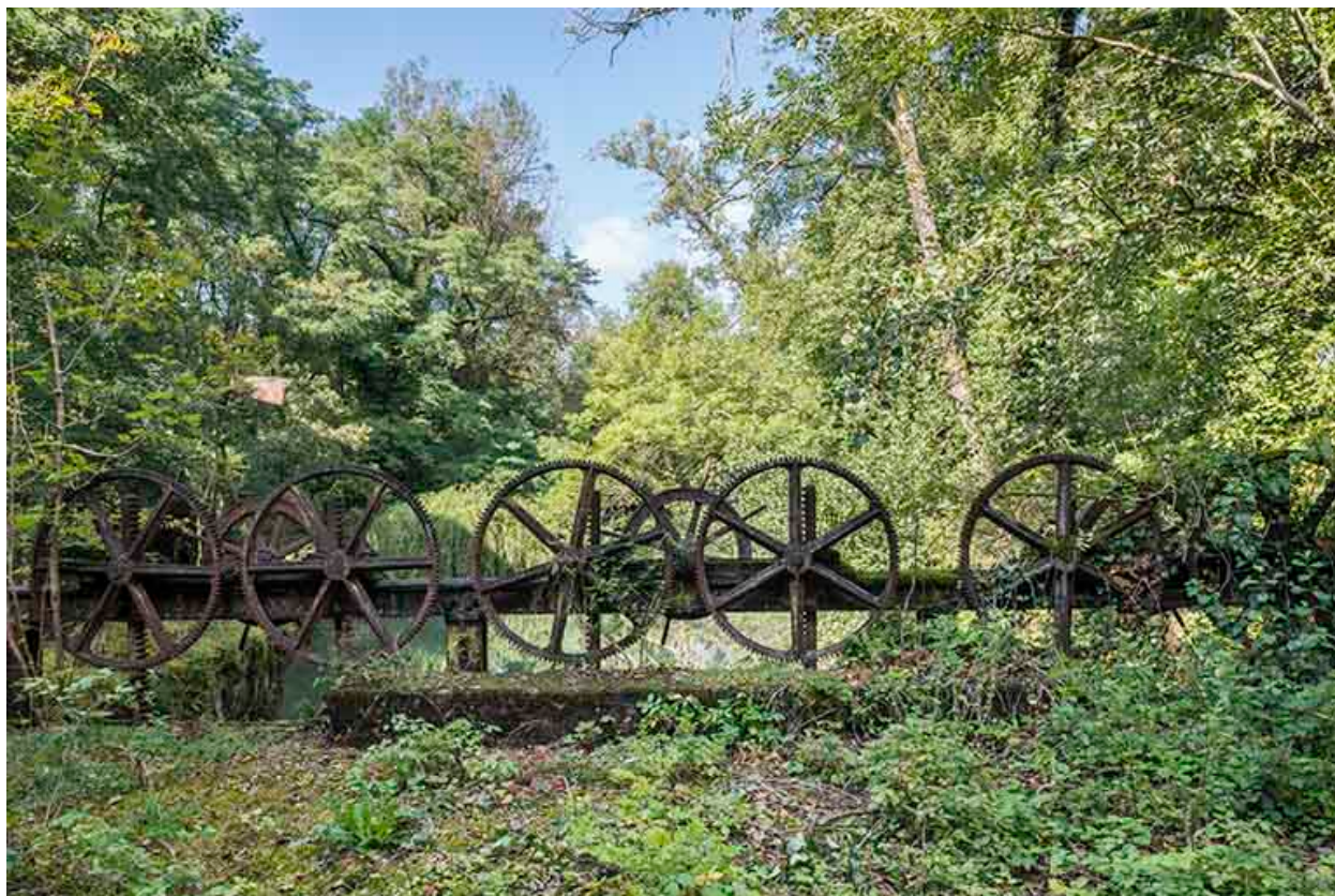
Mécanisme de levage du vannage (canal d'amenée).
