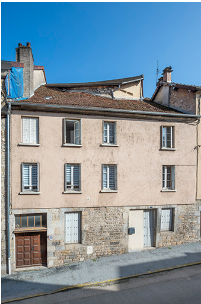
Façade ouest (rue Charles David).
