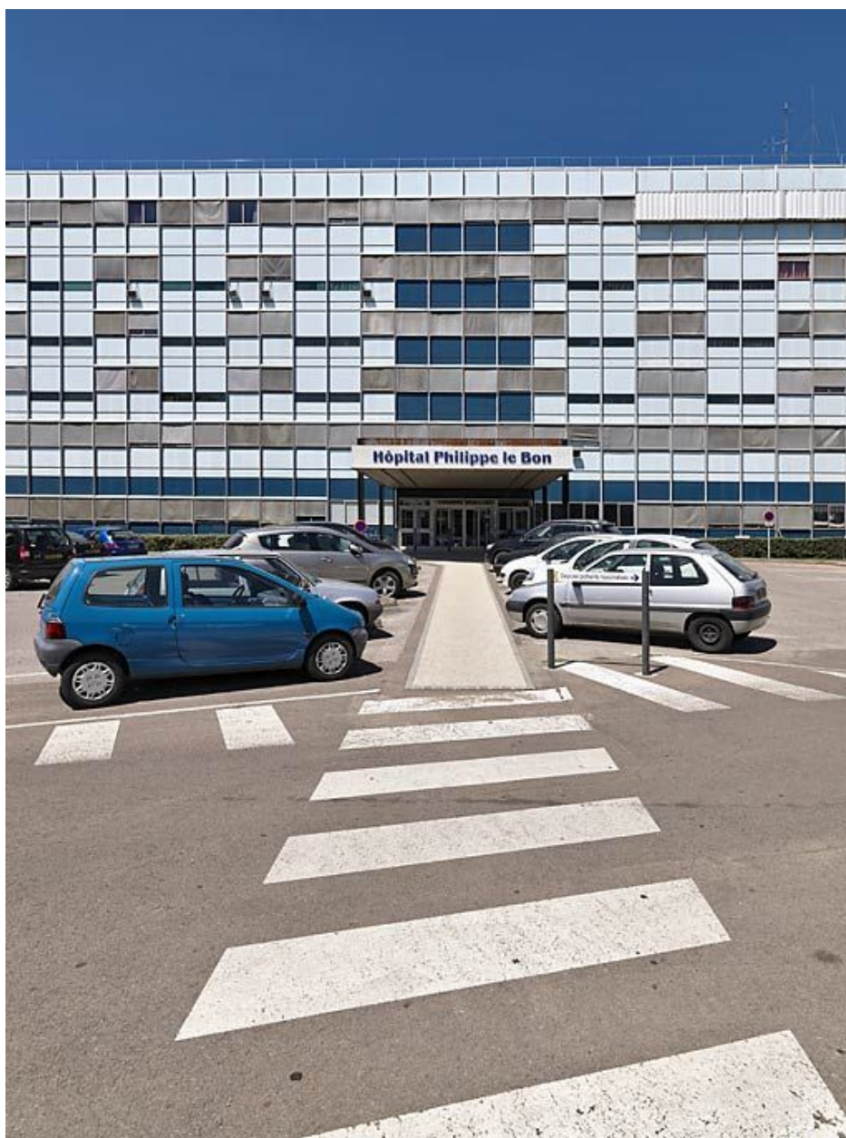
Bâtiment principal, partie centrale de la façade.
